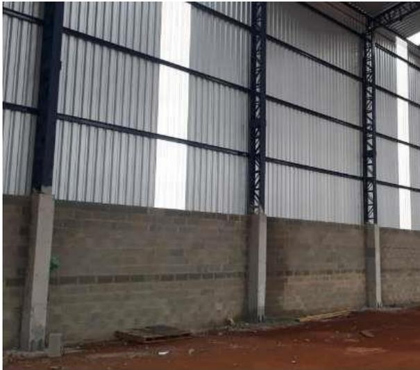
Figura 2 - Fechamento em estrutura metálica.
